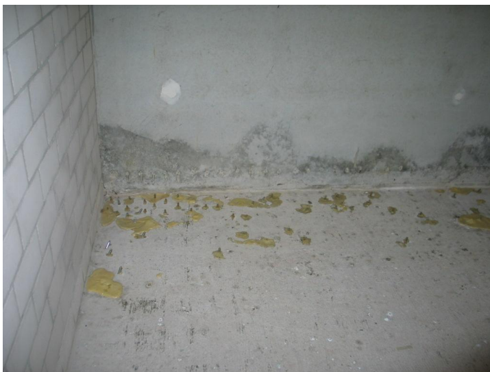
Abb. 1: Undichtigkeiten am Wandfuß
