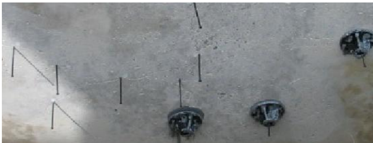
Abb. 4: Arretierstifte im Rissverlauf und aufgesetzte Klebepacker
