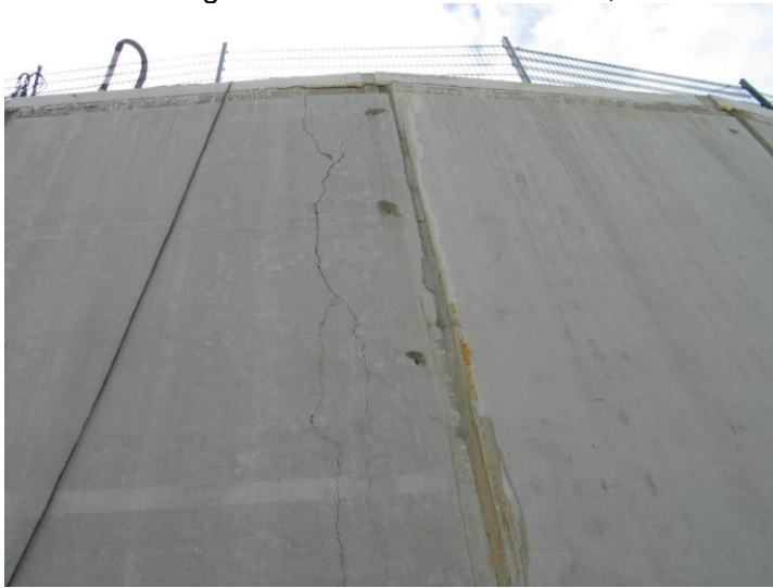
Abb.2: zerstörte Elementwand
