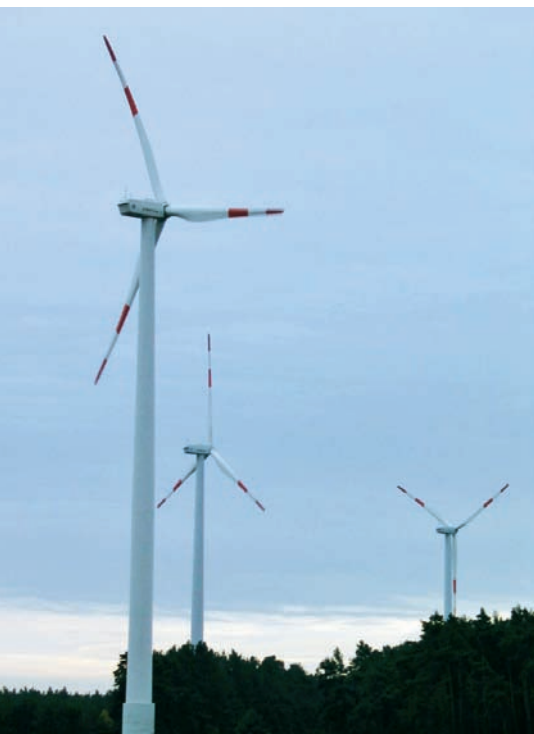
Bild 1: Beispiel einer Windenergieanlage GE 1,5 sl
