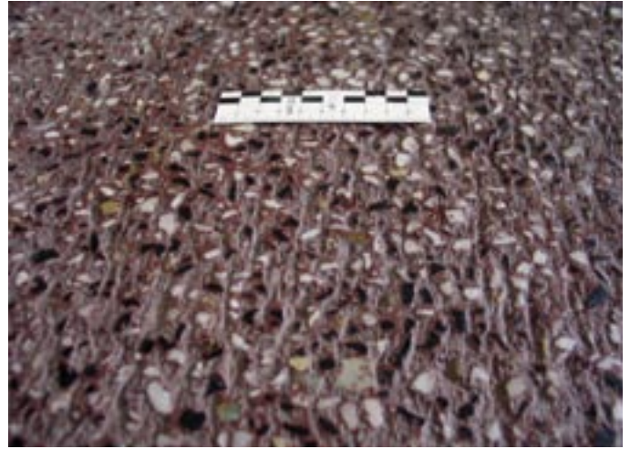
Bild 3: Oberflächentextur durch Aufrauen
