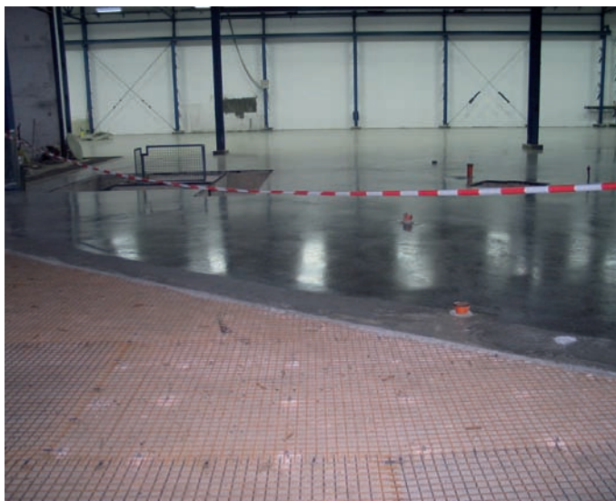
Die Oberfläche des Industrieboden ist fertiggestellt.
