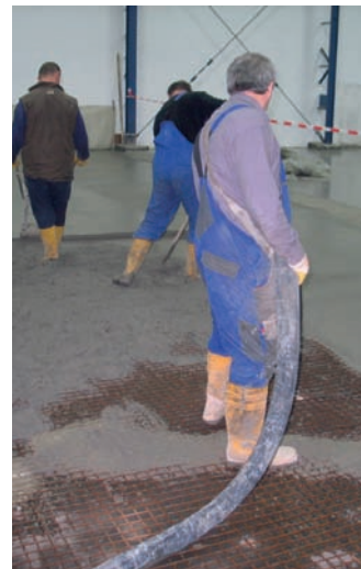
Der Estricheinbau erfolgte per Rüttelbohle.
